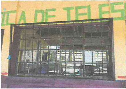
Foto1: VENTANAS Sustitución de ventanas; sistema de apertura: Corredizas, Perfiles color blanco estandar, Material del marco: PVC Material de la ventana: Vidrio, sellado perimetral. Aula 1 y 2
