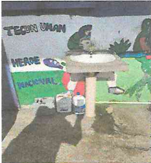
Foto 3:SERVICIOS SANITARIOS Y SUS ACCESORIOS Sustitución de lavamanos, accesorios y conexiones.
