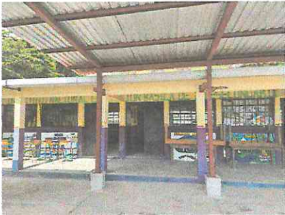
Foto 2: PINTURA EN MUROS INTERIOR Y EXTERIOR Preparación de la superficie y aplicación de pintura a dos manos, en paredes interiores y exteriores del establecimiento.
