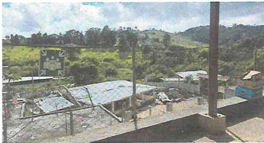
Foto 5: CERCO O MURO PERIMETRAL Sustitución malla de acero galvanizado en perímetro del establecimiento, con instalación fija y tensa, anclajes metálicos en intervalos regulares
