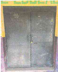
Foto 6: PUERTAS Mantenimiento a puerta metálica existente retiro de óxido, suciedad y pintura deteriorada; incluye cepillado, lijado y aplicación de pintura. Aula 1,2,3
